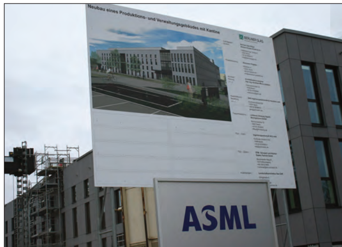
Auf dem ehemaligen Gelände von Berliner Glas investiert der holländische Konzern ASML auch in den Neubau eines Produktions- und Verwaltungsgebäudes. Foto: Bothe
